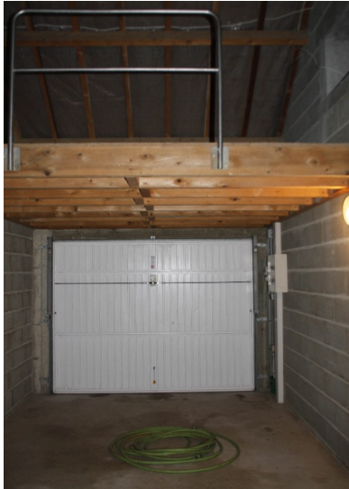
Garage avec grenier
